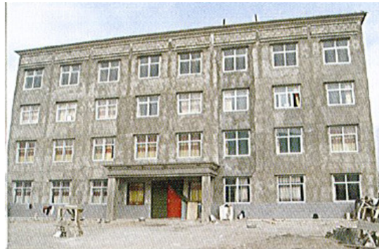
孤儿院建好的4层楼房
